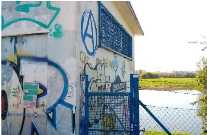
Pumpenhäuschen und Mahlbusen Grimmer Vorstadt
